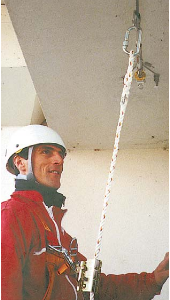
Montage an der Decke/ Überkopfmontage
