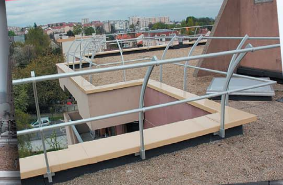
Barrial fix – Befestigung Attika Oberseite
