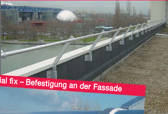
Barrial fix – Befestigung Attika Innenseite
